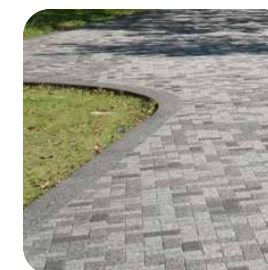
Groen plein uitgevoerd in betonstraatstenen
