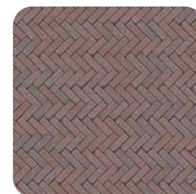
Gebakken klinkers, keiformaat, keperverband
